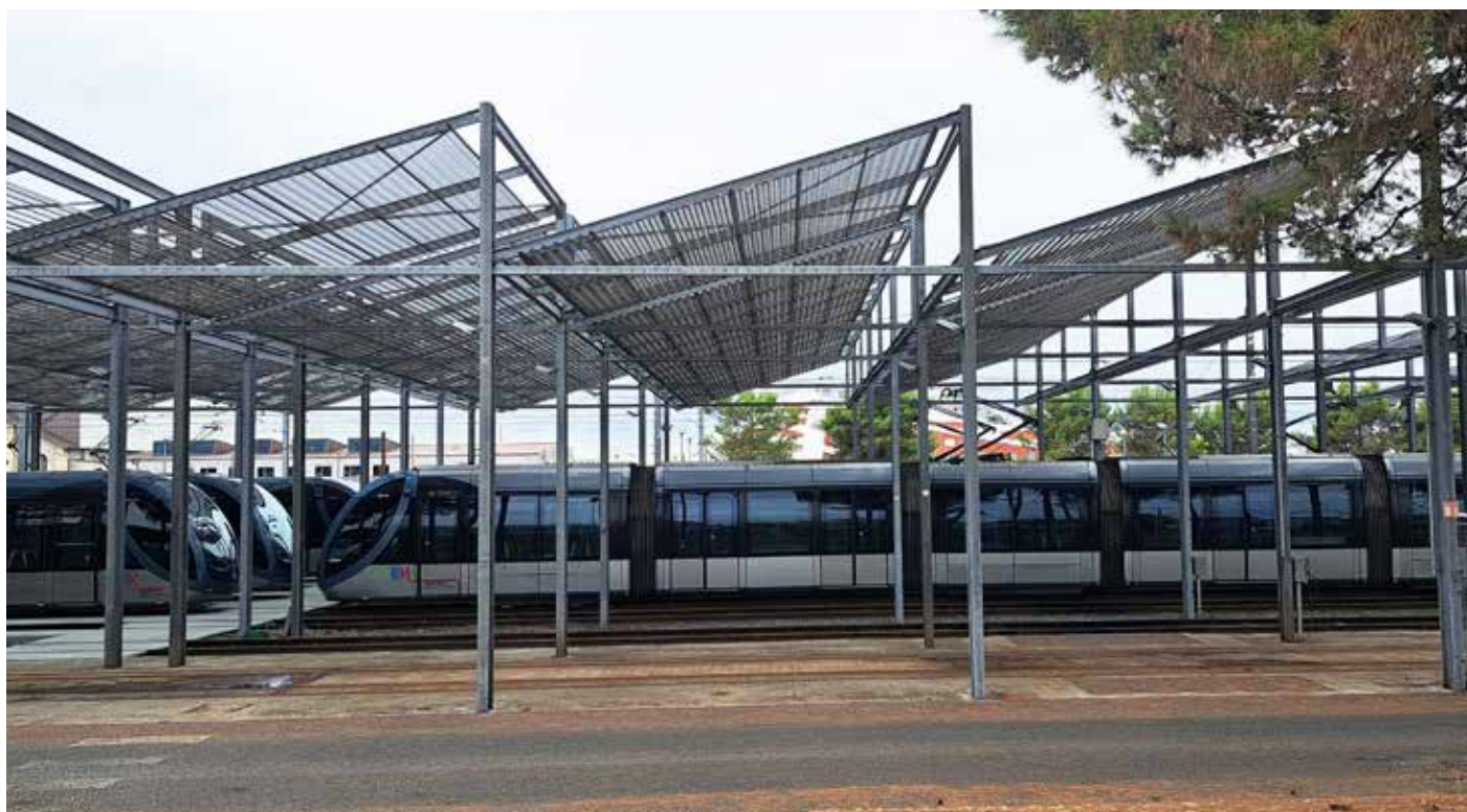
Ombrières sur les aires de stationnement des rames de tram à Bordeaux @PQN-A
